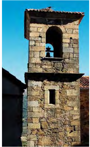
Torre de la Iglesia de Santa María de Gracia y detalle de una ventana
