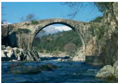
Puente romano de Alardos
