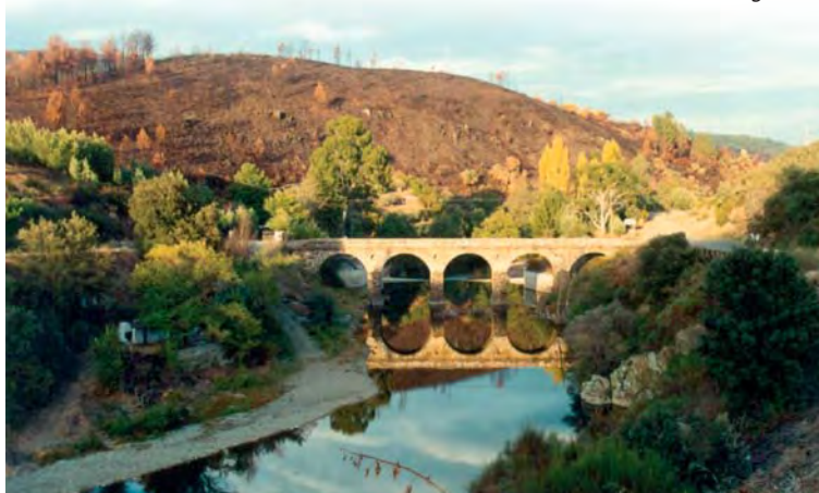
Puente sobre el río de los Ángeles
