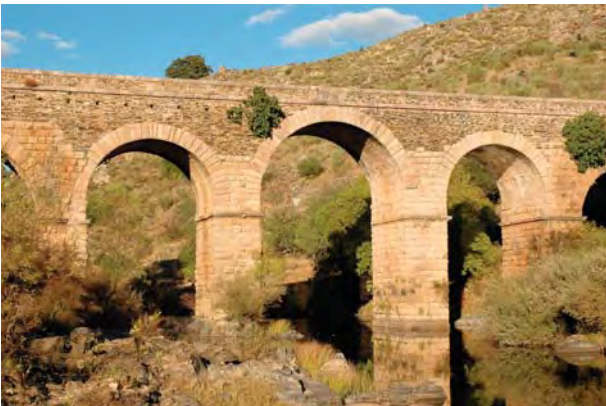
Puente de Segura, sobre el río Erjas.
