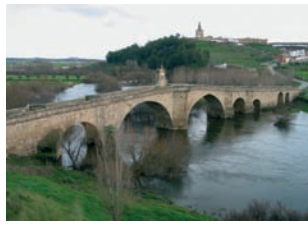
Puente romano sobre el Jerte
