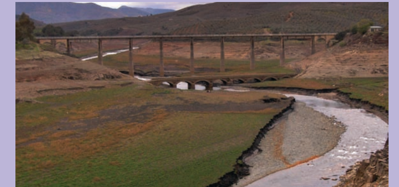
Puente normalmente sumergido por el río Alagón en La Pesga
