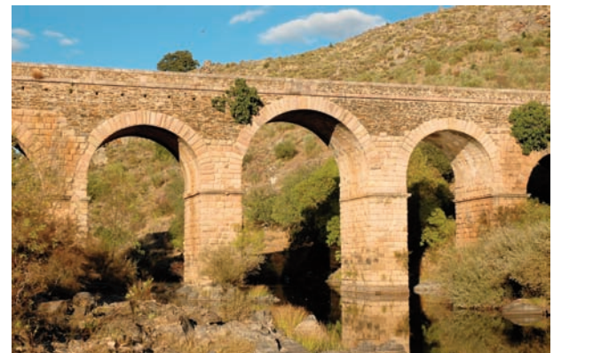
Puente de Segura, sobre el río Erjas.
