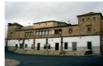
Palacio de los Marqueses de Valdefuentes
